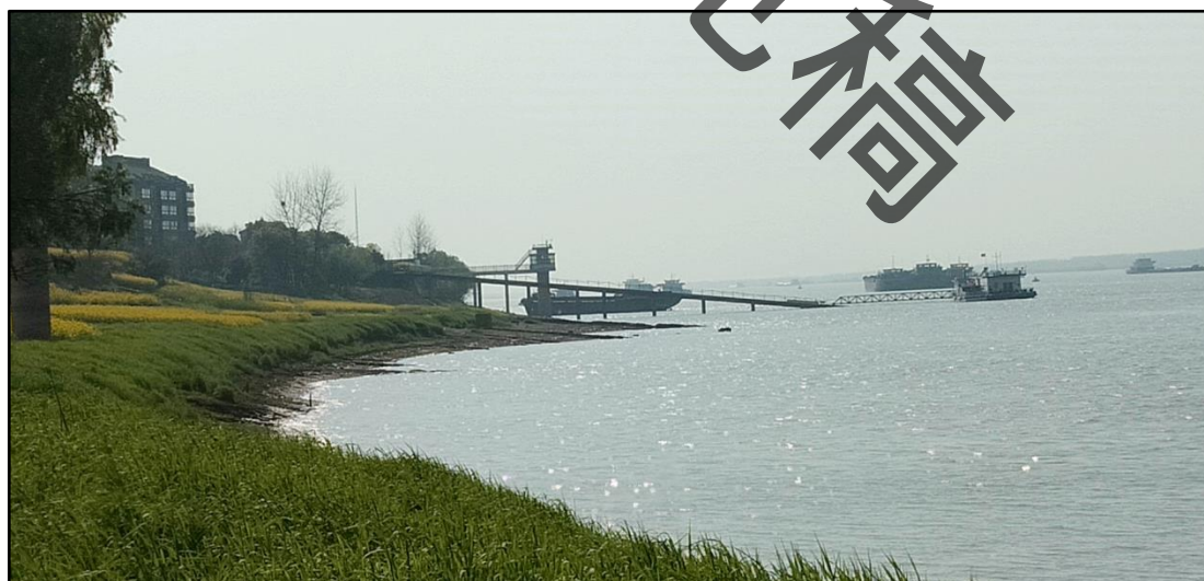
图 3.3-1 梅龙街道建筑公司自来水厂取水口
